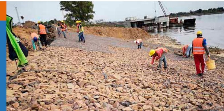
Los colchones Reno se utilizan para los bancos del río y protección de socavación, en revestimientos de canales para el control de erosión y para la estabilidad de taludes.
